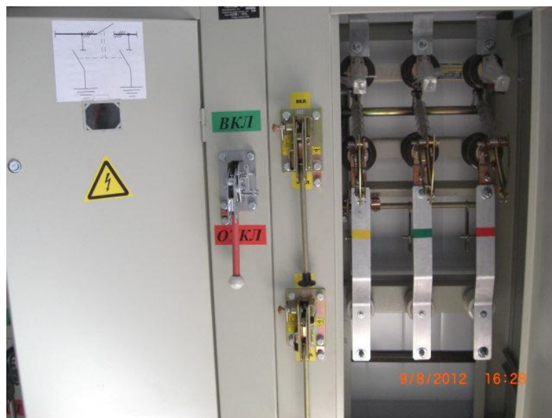
Фото 2. Камера КСО-393-03 УЗ (ВНА-10/630)
